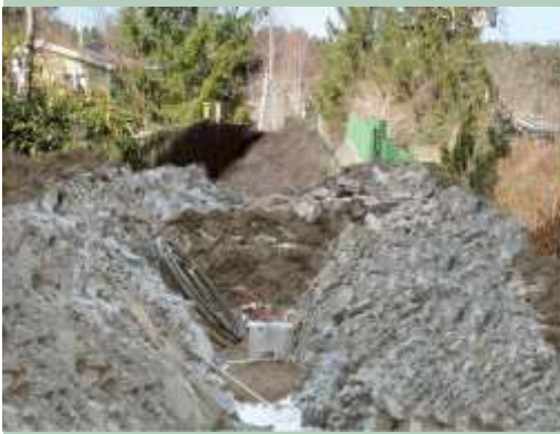
Sama katu kuin edellä, kaivettuna täyteen syvyyteen
