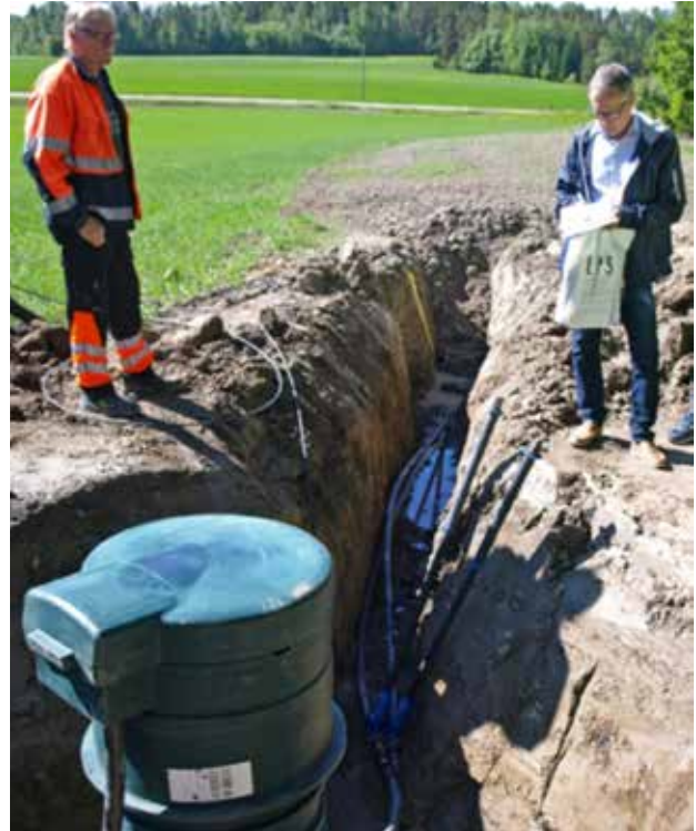
Käynnissä pumppaamon asennuskoulutus.
