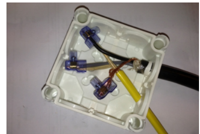
Skruva på lock när skarven är klar
