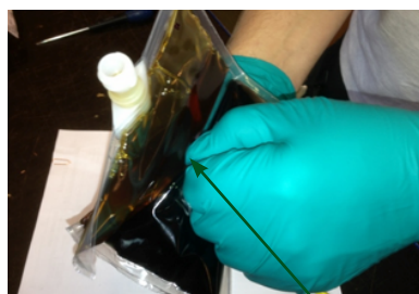
Gjutmassan knådas till den blir varm
